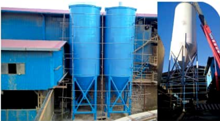
مخزن تیکنر بدن پارو - در حال نصب
